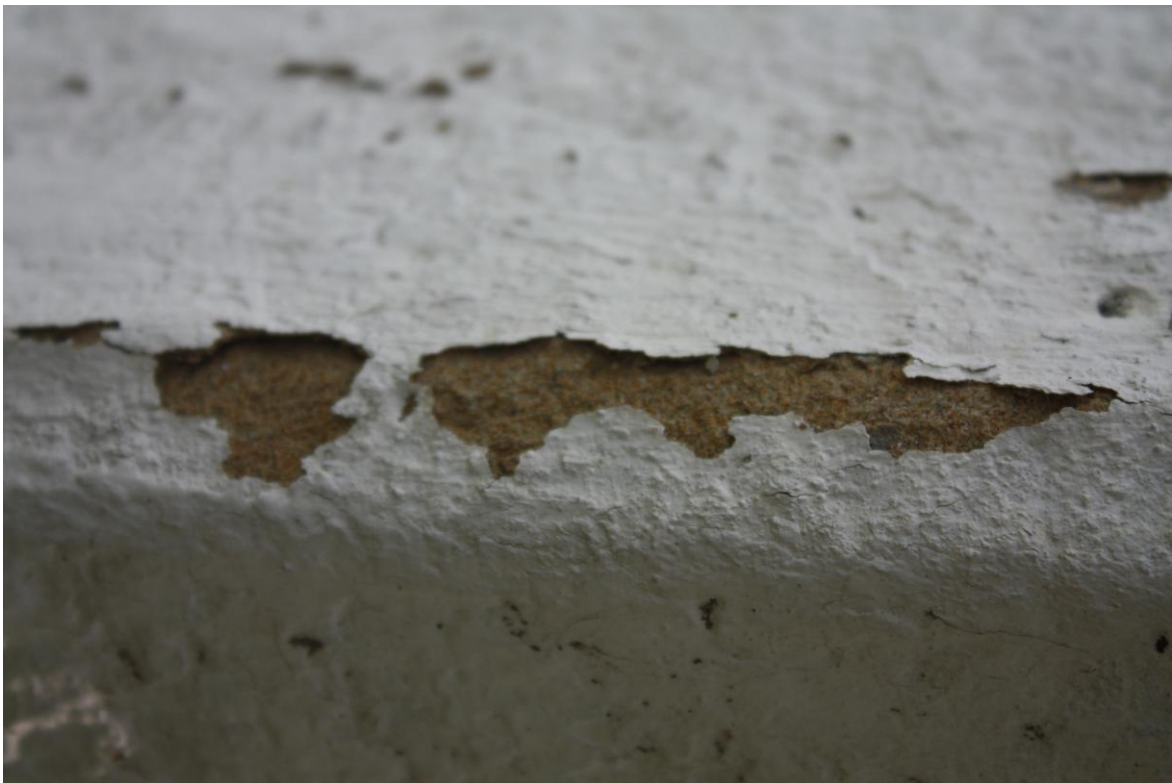
Fot. 8. Obec Hladovka, okres Tvrdošín, v Žilinskom kraji, na severe Slovenska. Kamenný kríž s vyobrazením Krista a Sedembolestnej Panny Márie. Pohľad na povrchové zvetranie kameňa v dôsledku deštruktívneho účinkovania olejovej farby. Fot. M. Książek 2016
